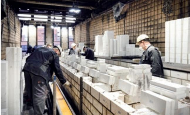
Prüfung und Ausbesserung der Fugen in den neuen Heizwänden
