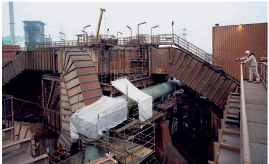
Der neue Luftverteiler „Tarantula Giganta“ (Spinne) ermöglicht die gleichmäßige Zugabe warmer Prozessluft zur Koksgruseinsparung.
