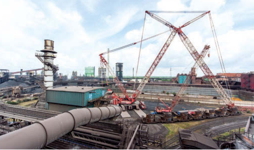
Blick vom Stahlwerk auf die Vormontage und Lagerfläche
