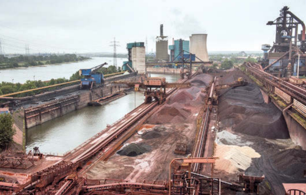
Der HKM-Hafen mit dem Rohstofflager
