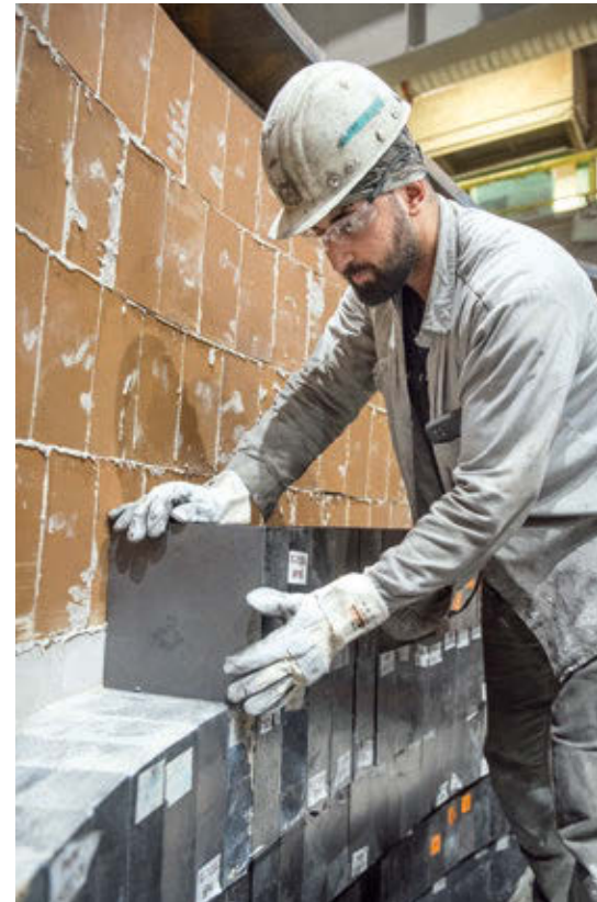
Sefa Ascı mauert hier einen Verschleißfutterring in einer Stahlgießpfanne.
