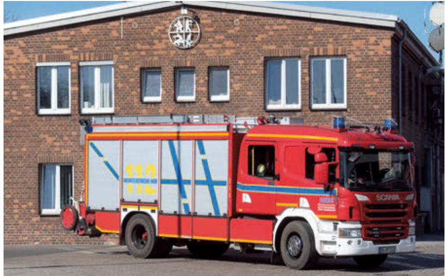
Auch das alte Wachgebäude ist weiterhin in Betrieb und wird von der Verwaltung und der Feuerlöscherwerkstatt genutzt.
