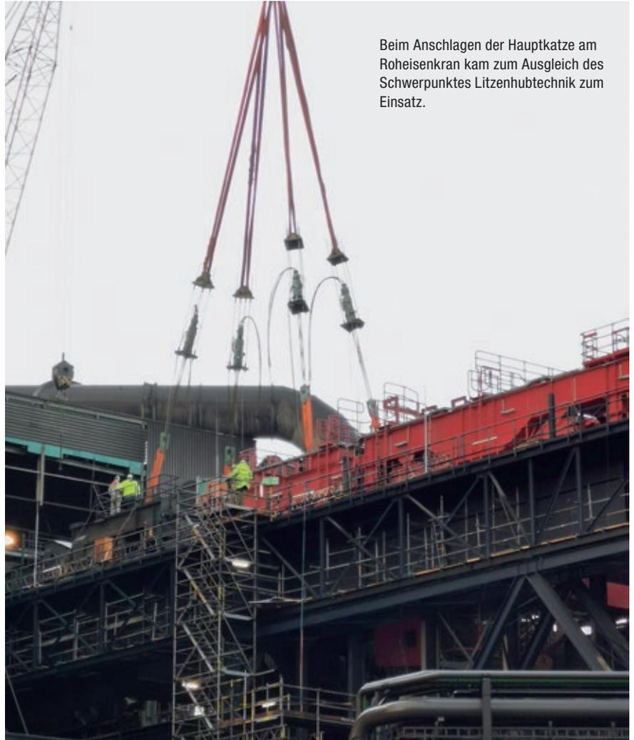
Beim Anschlag der Hauptkatze am Roheisenkran kam zum Ausgleich des Schwerpunktes Litzenhubtechnik zum Einsatz.
