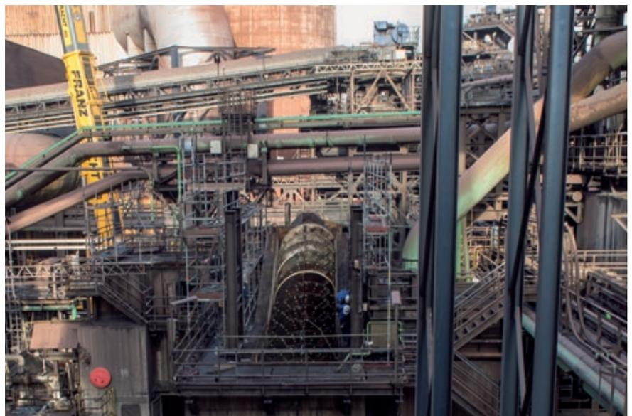
Granulierschnecke mit bereits demontierter Haube.
