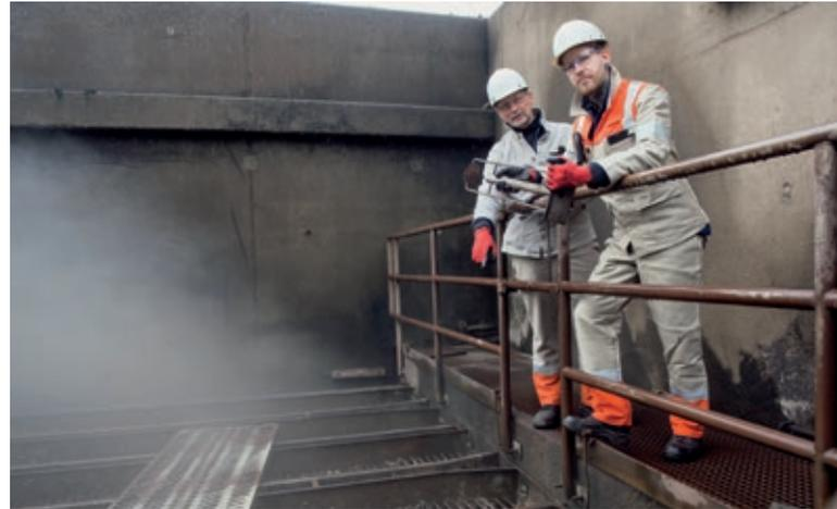
Peter Lenz (TR-HS) und Hendrik Dräger (TR-HS) inspizieren die Verteilerrinnen des Kühlturms und die dort eingesetzten Wasserdüsen.
